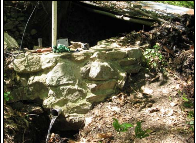
Photo 2 - La surverse du bassin de la source du Château.
