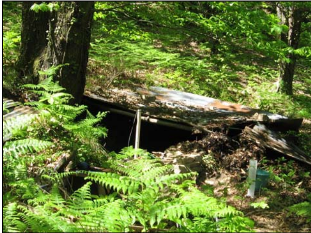
Photo 1 - La source du Château : la couverture en tôles et le tube porte-sonde de la station hydrométrique.
