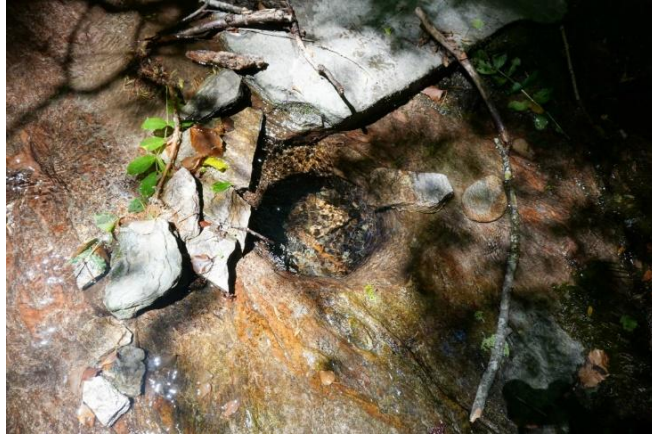
Photo 6 : traces d'encoches (systèmes de retenues permettant de guider l'eau par un béal afin de remplir un grand réservoir situé à gauche du moulin (source Errero, 2022))
