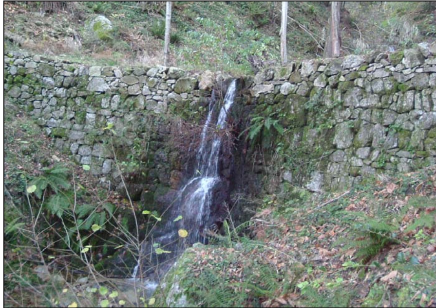
Photo 4 - Tancat en aval de la station hydrométrique du ruisseau de la Bastide (4,5 m de haut).
