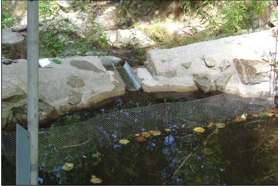
Photo 2 - Filet anti-feuilles à la station hydrométrique du ruisseau de la Bastide.
