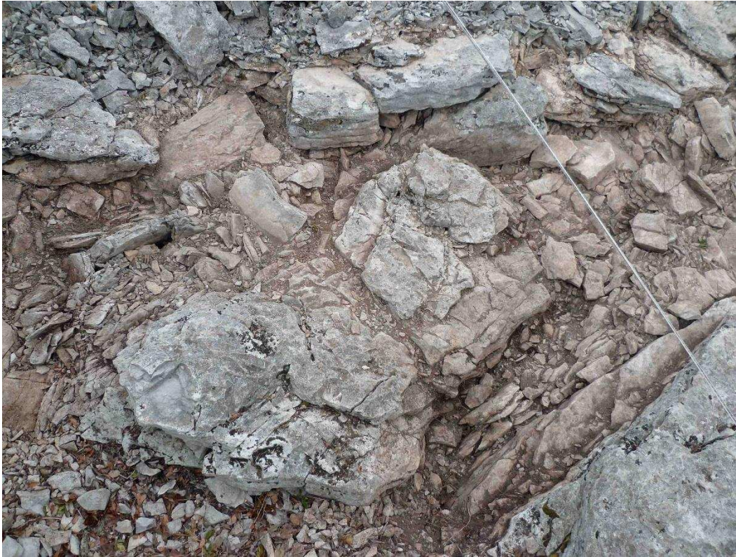
Figure 149 : Implantation du pérystalithe à l'ouest et comblement des failles du substrat.
