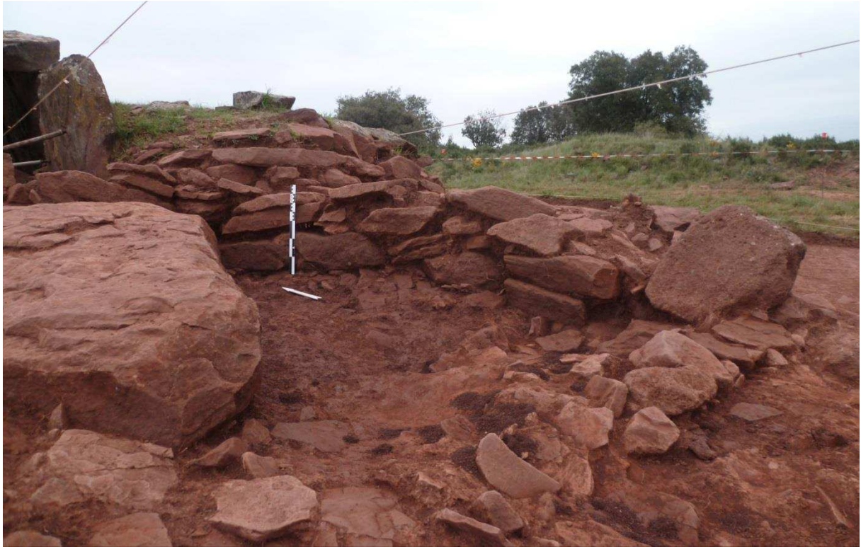
Figure 282 : Vue depuis l'ouest du mur interne (MR4) de l'antenne sud et au premier plan de l'US44.
