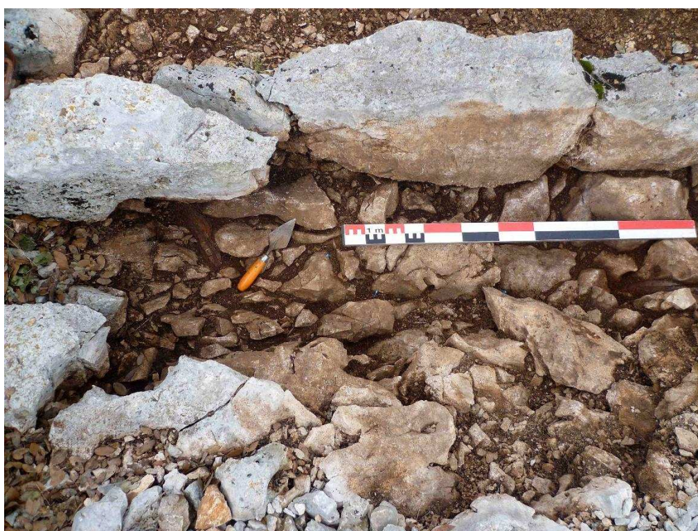
Figure 128 : Vue du sondage 2 à la fin de la fouille, depuis le sud. Les dalles de la paroi du couloir sont directement posées sur le substrat calcaire lapiazé.
