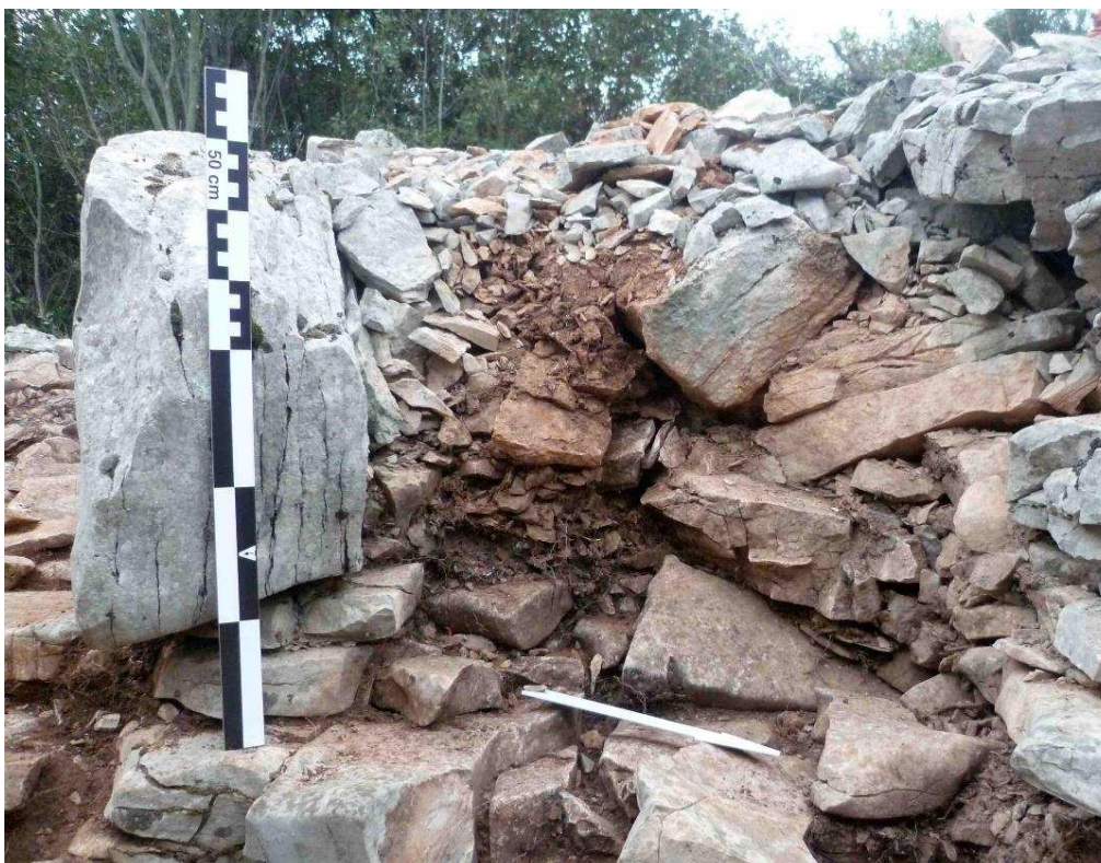
Figure 156 : Mur de retour (MR2) très érodé de la chambre (depuis le nord-est).
