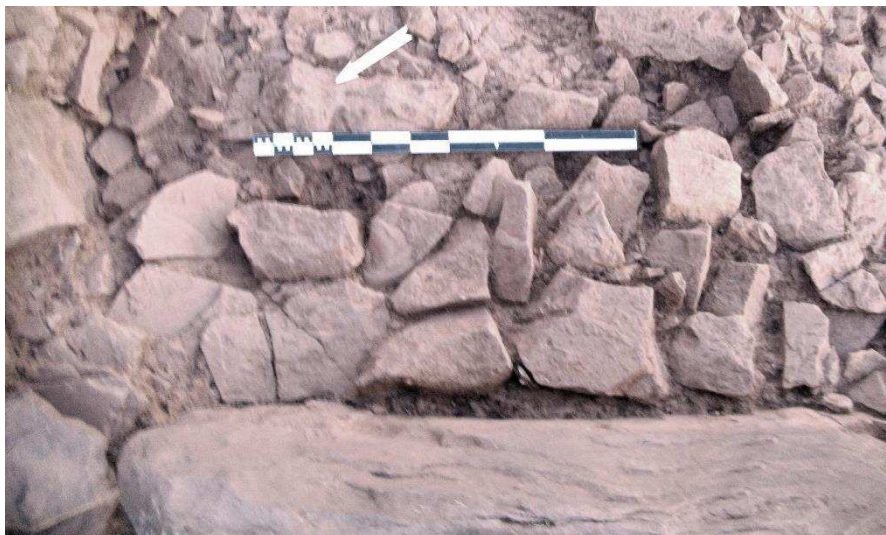
Figure 246 : Détail de l'US77, structure de calage de la dalle plantée du couloir (depuis le N-O).
