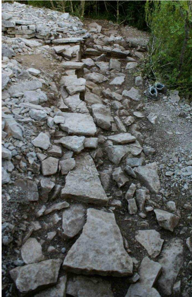
Figure 190 : La façade concave de la phase 2 (depuis l'ouest)
