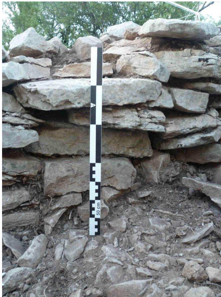
Figure 174 : Coup de sabre visible dans la paroi sud-ouest du couloir (à gauche de l'échelle).
