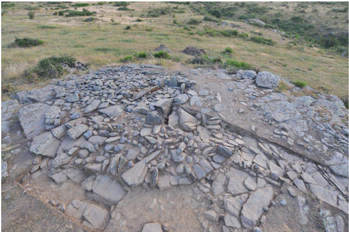
Figure 26 : Vue du quart est, avant et après le démontage des effondrements au-delà du mur périphérique du tumulus (en bas photographies de M. Robert).
