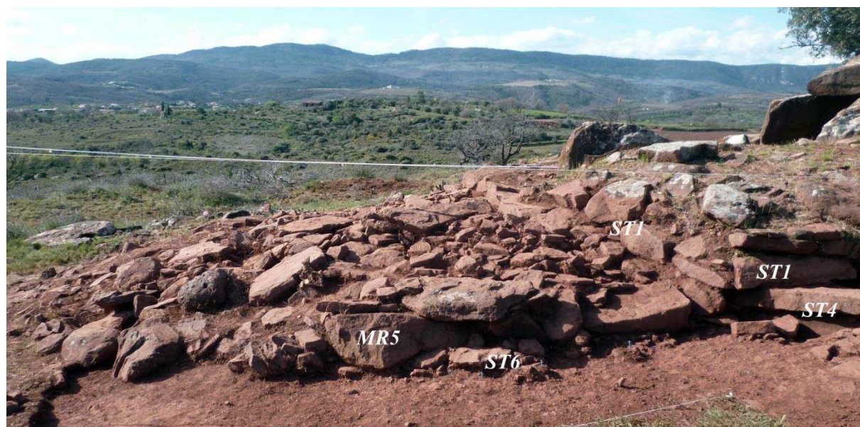
Figure 281 : Vue frontale de la paroi externe (MR5) de l'antenne sud
