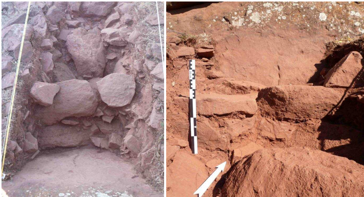
Figure 215 : Renfort interne, constitué de gros blocs et conservé sur deux assises (ST 3), depuis l'orthostat et en façade.
