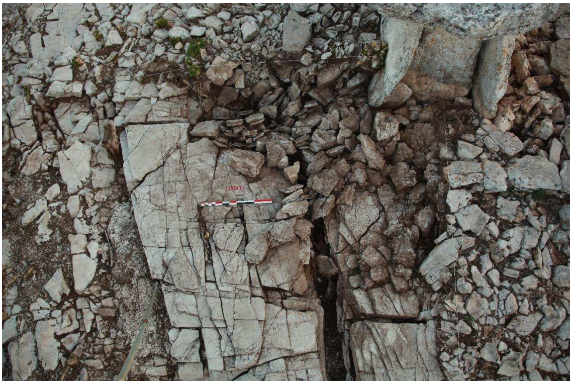
Figure 321 : Vue zénithale du quart nord-est après le démontage de la première couche de bloc 5001. La couronne périphérique n'est pas conservée dans cette zone. On remarque un creusement karstique très bien marqué d'axe nord-sud. Près de la coupe, un assemblage très jointif semble constituer un dispositif de blocage très bien organisé qui vient en comblement du point de soutirage (US 5003).
