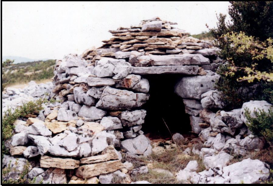
**Photo 52 - Capielle sur le versant occidental du Serre d'Aubanel. Le toit et une partie des murs sont bâtis avec des dalles de calcaires gréseux crétacés provenant d'un affleurement tout proche.**
